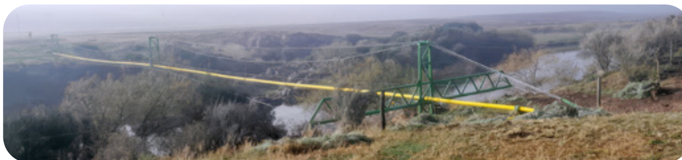
Gasoducto Estomba-Pringles. Cruce aéreo arroyo Sauce Grande, reacondicionado en 2025.
